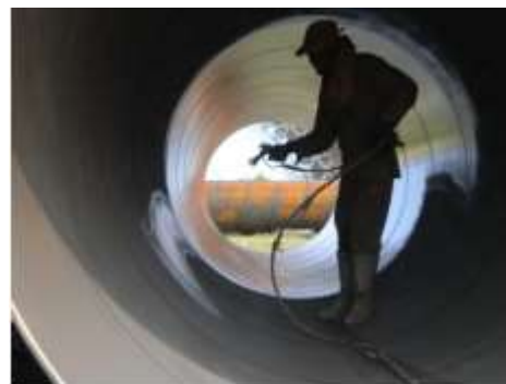
Aplikasi Coating Internal Pipe
