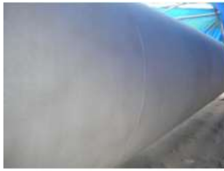
Pipa setelah Sandblasting
