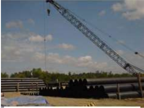
Crane mengangkat pipa dari stock
